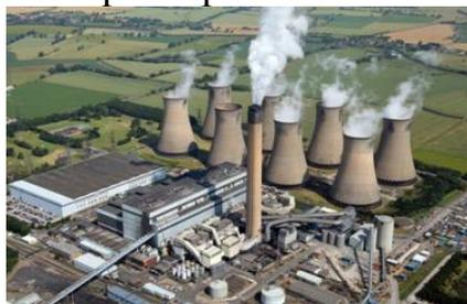
Различают ТЭС и теплоэлектроцентрали (ТЭЦ). Первые вырабатывают только электрический ток, а вторые не только генерируют электричество, но и дают тепло в системы отопления и горячего водоснабжения.
